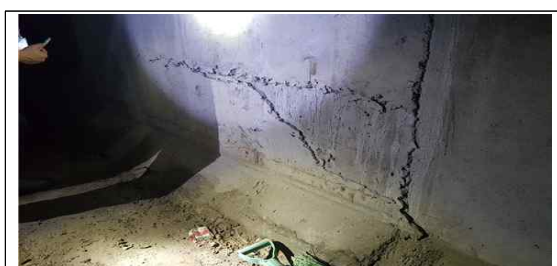
하수암거 내부 보수공사 콘크리트 탈락
